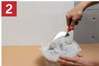
2 Trockenmasse von Hand durchmischen.
